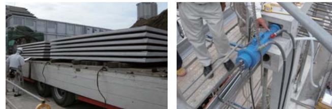
運び込まれたプレキャストコンクリート材は、短期間のうちに組み上げられていきました。内部には、強靱なワイヤーが張られ、引っ張り合う力で、より建物としての強度を増しています。
