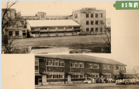
▲1932年（昭和7年）鉄筋校舎と木造校舎
